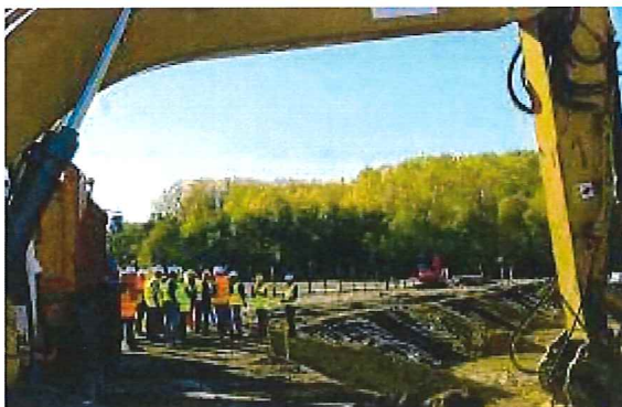
Les élus et responsables ont visité le chantier.
