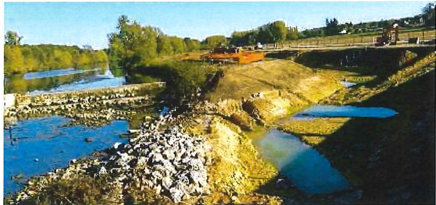
A gauche, le Cher, et à droite, le creusement du bras de contournement
