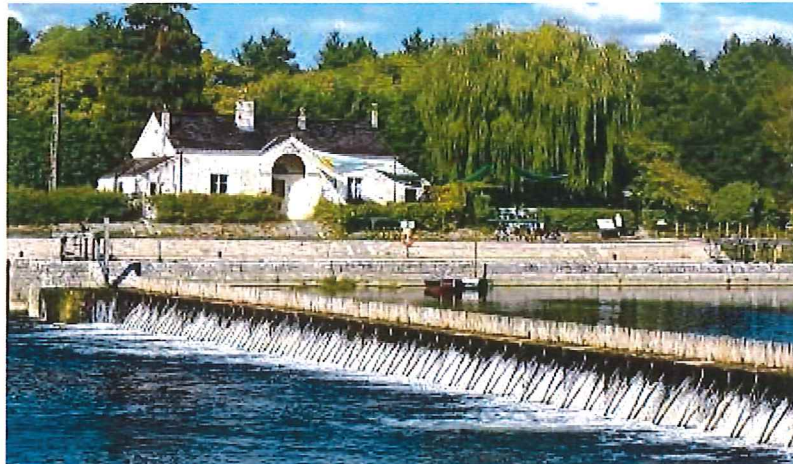
Le barrage à aiguilles de Civray-de-Touraine est relevé tous les ans à la fin du mois de mai pour garder en eau les arches du château de Chenonceau.
