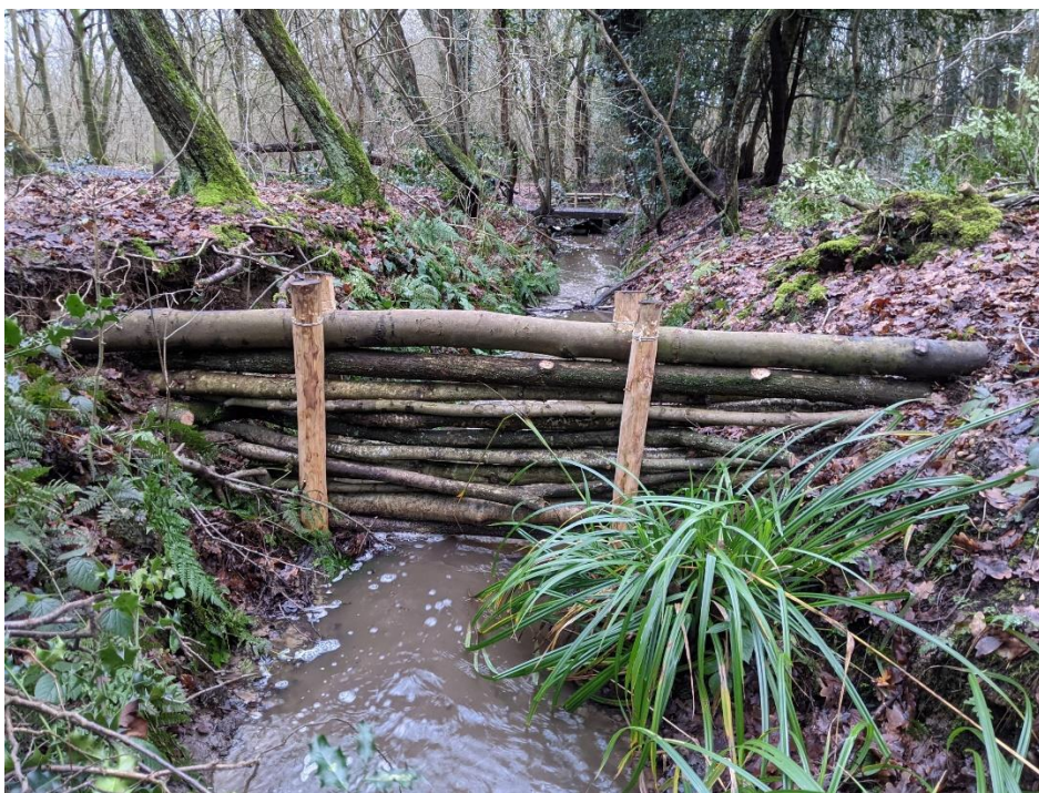
Figure 21. Exemple de barrage partiel en bois (source : Thames21.co.uk). Sur le Fouzon, la base du barrage serait surélevée pour avoir une revanche de 2m avec le fond du lit mineur et une ouverture de 3m de largeur.
